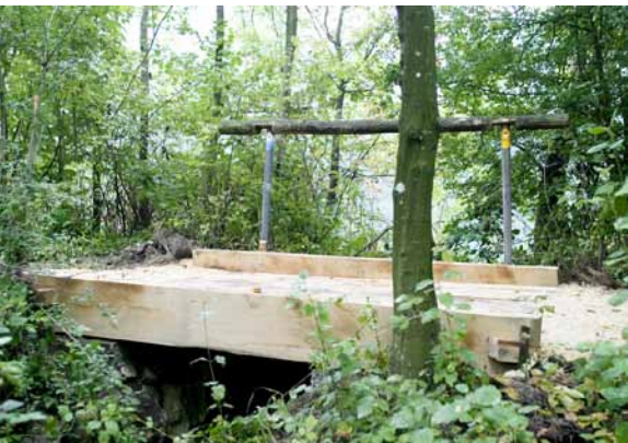
Sicherheit wieder gewährleistet: Die neue Brücke an der Aare ist stabiler als je zuvor.
