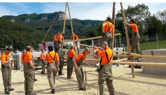
Brückenbau im ziko Balsthal
